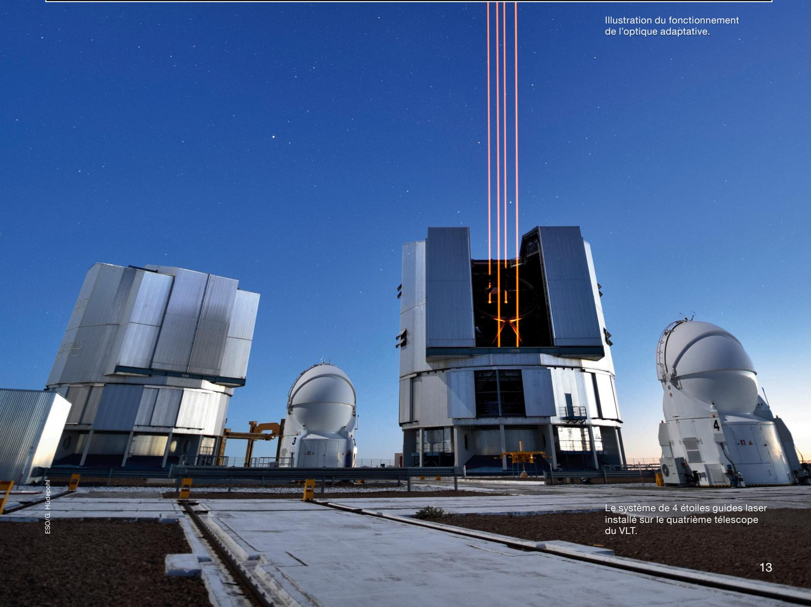
Le système de 4 étoiles guides laser installé sur le quatrième télescope du VLT.
