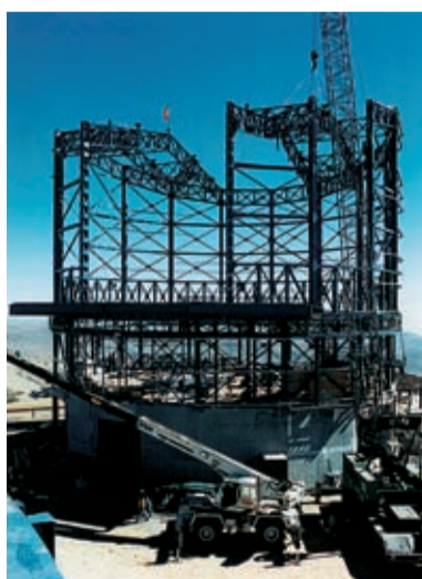
Anfang 1996 wurde der erste Teleskopdom errichtet.
