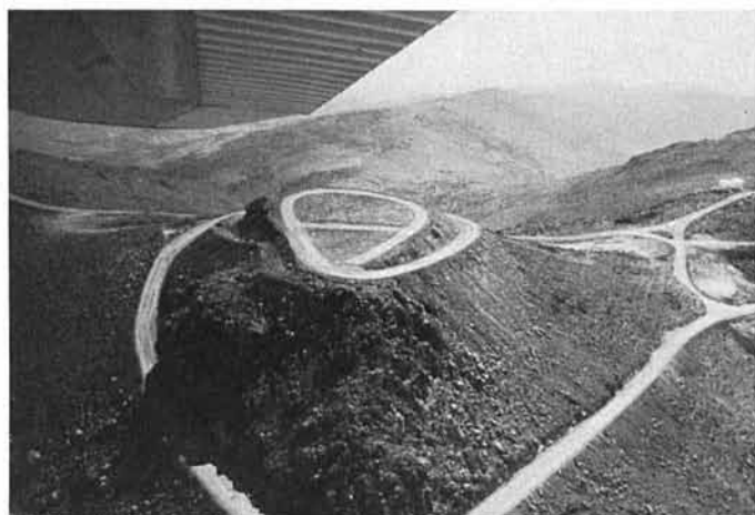
Fig. 3: Vue aérienne du sommet principal de La Silla, côté est, avec sa route d'accès en construction.
