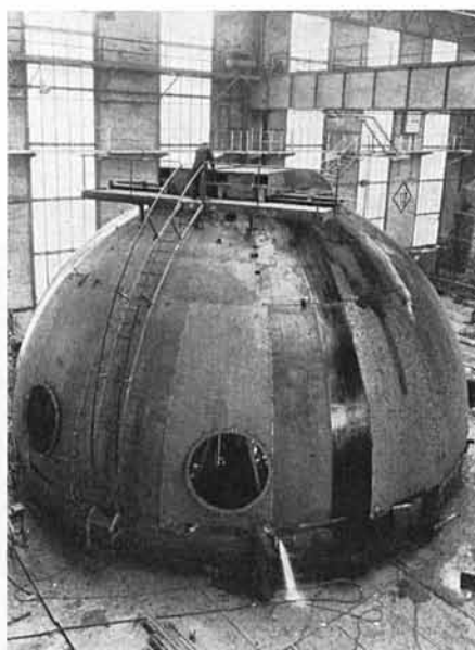
Fig. 9: Coupole pour le télescope spectrographique de 1,52 m dans les ateliers de Seibert-Sécométal à Sarrebrück. On aperçoit les trous circulaires pour les grands ventilateurs.
