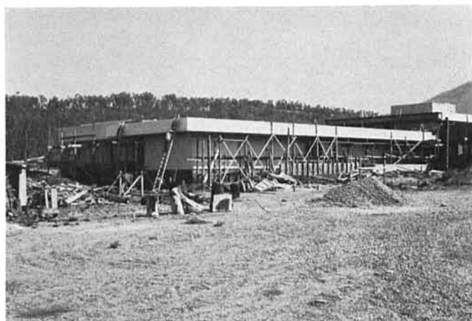
Fig. 17: Centre de l'ESO à Santiago. Bâtiment principal, partie sud de la façade est.
