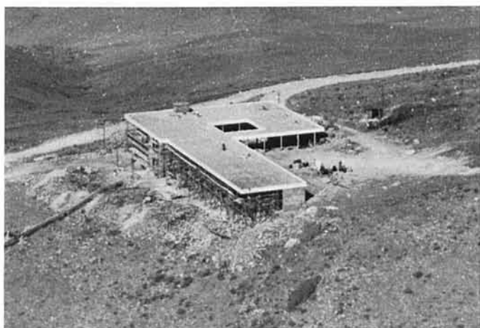
Fig. 4: L'hôtel de La Silla en construction.
