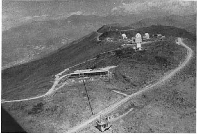
Fig. 1: Vue aérienne de La Silla, côté ouest. Au premier plan, installation de chauffage. Au centre, l'hôtel.
